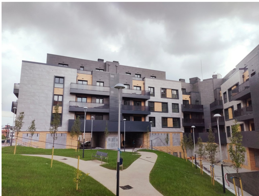
Goyetalde– Urduliz (Bizkaia) - Obra nueva edificación.
